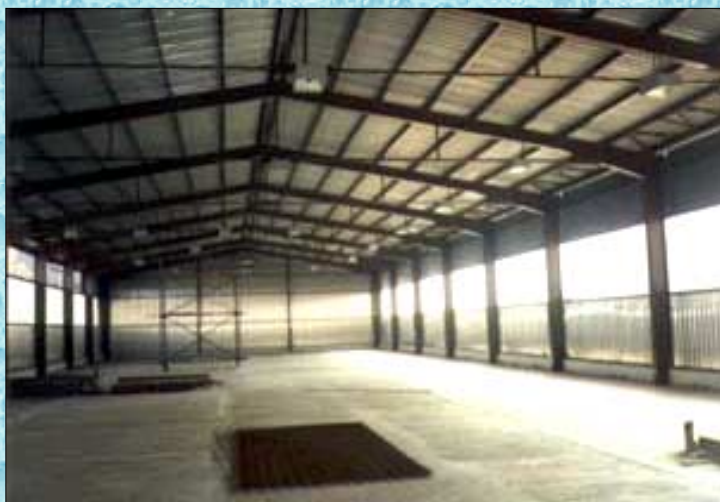
Ocelová konstrukce haly
