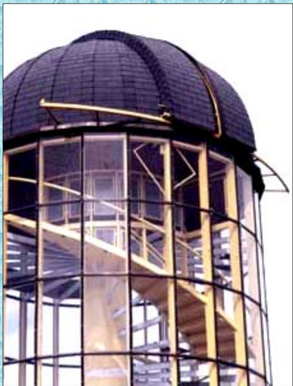
Ocelová konstrukce Školní hvězdárny
